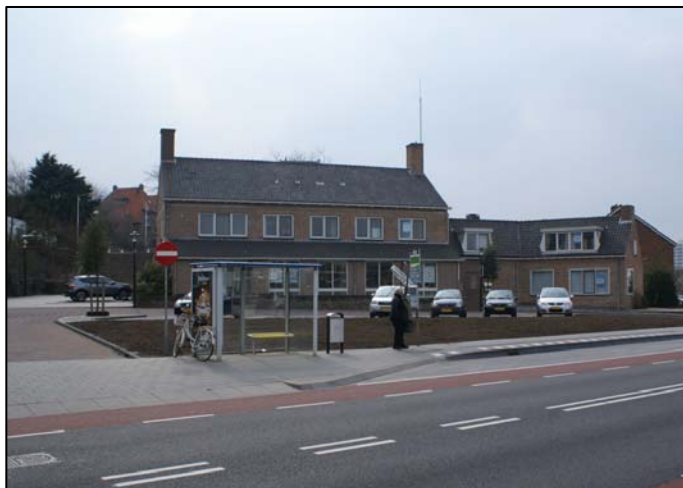
Aanzicht van de bebouwing in het plangebied. Zichtbaar is het centraal gelegen hoofdgebouw en het noordelijk gelegen bijgebouw.
