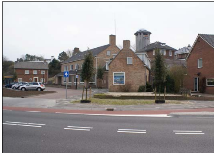
Aanzicht van de zijgevel van het bijgebouw, welke is gelegen aan de Huis ter Duinstraat. Het voorerf is thans geheel verhard.
