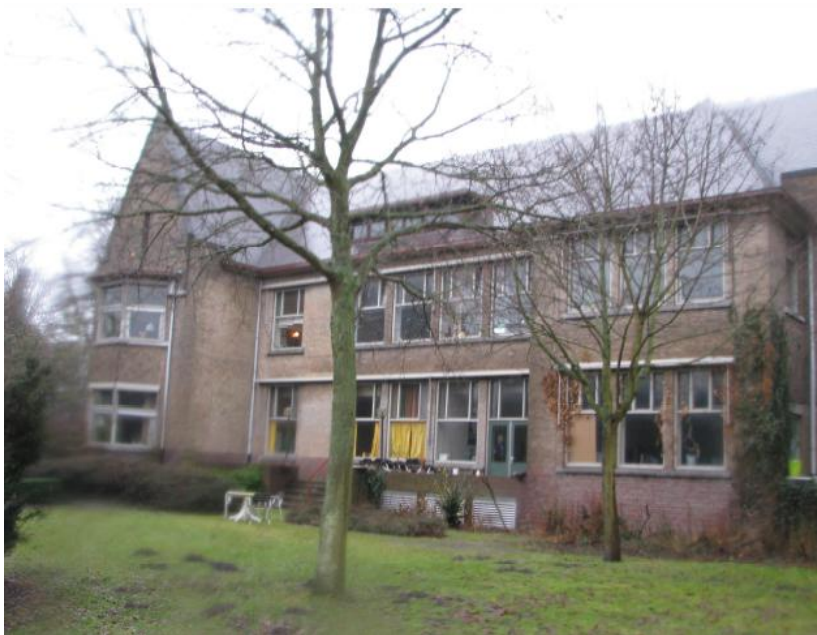
Foto bestaande situatie
