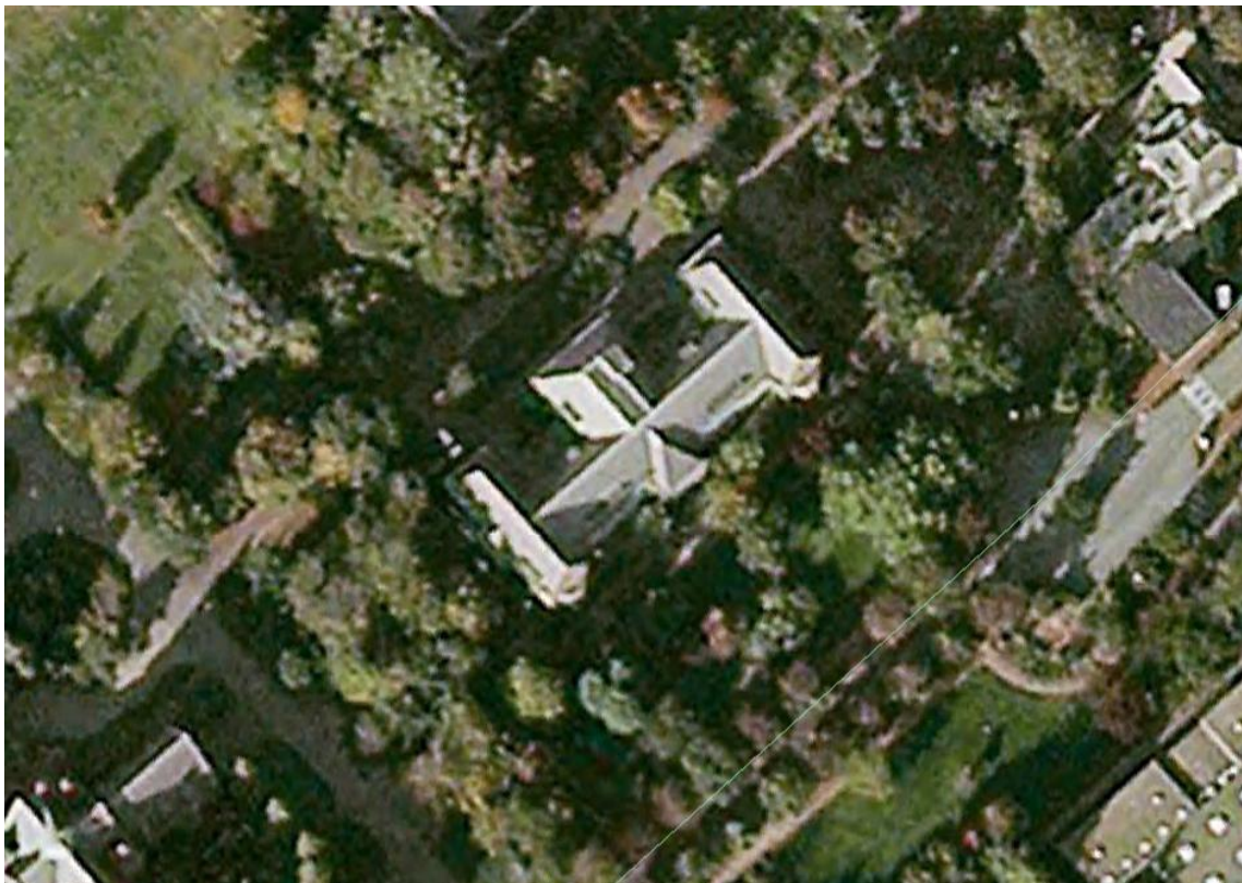
Detail gebouw Paulus (bron: Google Maps)
