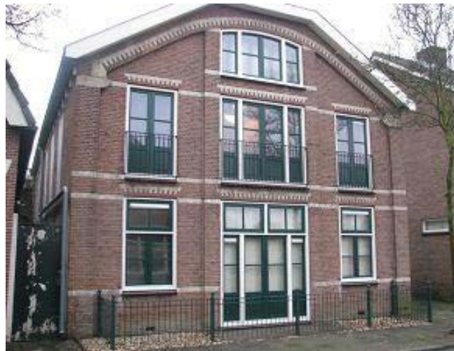
Voormalige schuur als woning
