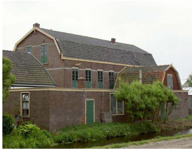
Woningen en schuur met mansardedaken
