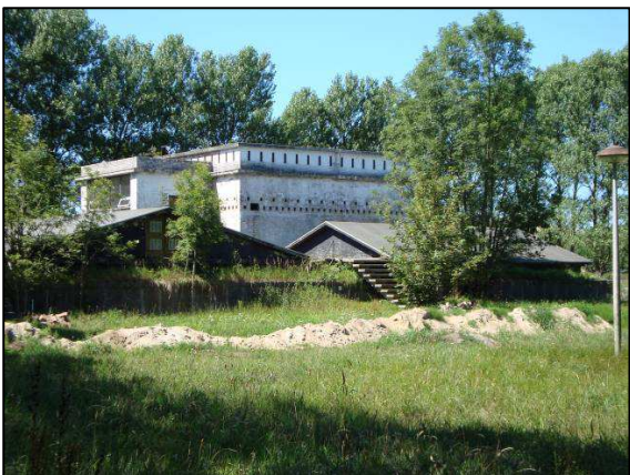
Afbeelding: voormalige waterpompstation
