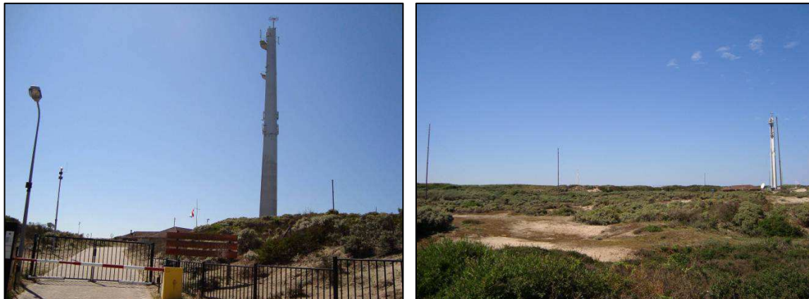
Afbeelding: entree marineterrein met zicht op het gebouw en de circa 40 meter hoge mast (links) en enkele masten gezien vanaf het fietspad (rechts)
