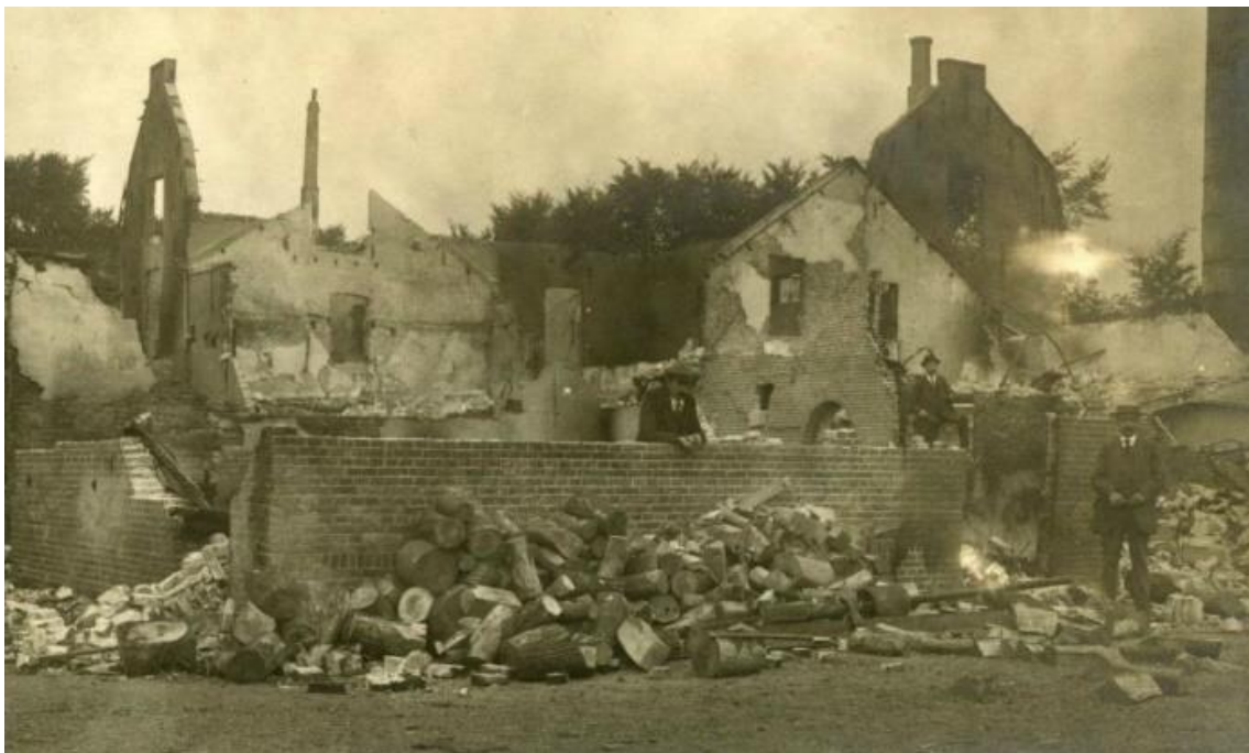
Afbeelding: NV Noordwijksche Speelgoederen en Kleine Houtwarenfabriek De Kroon na de brand
