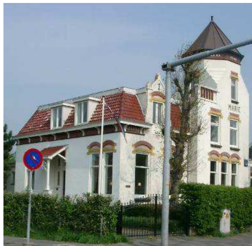
Pand op splitsing van Dompad en Lijnbaanweg
