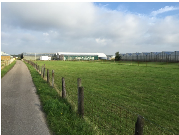
Zicht vanaf entree op bedrijfspand en kassen
