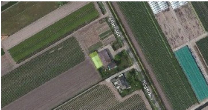
Figuur 3. Saneren schuurkas Wilgendam (bron: Google)
