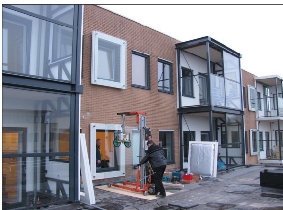
Foto II.1 Aanzicht glazen gevelgeluidschermen
