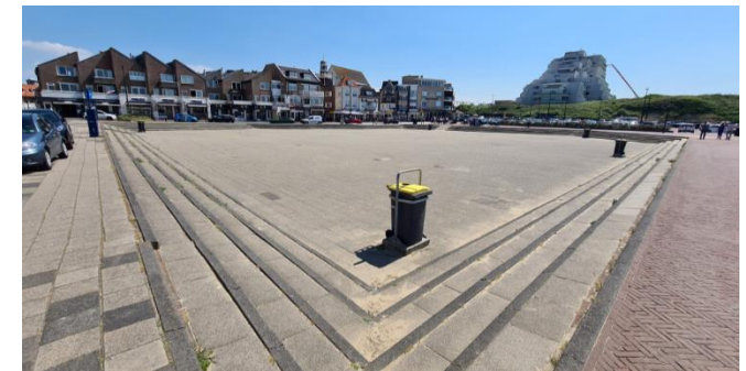
Figuur 6: Plangebied gezien vanaf kruising Oliebrug en Palaceplein
