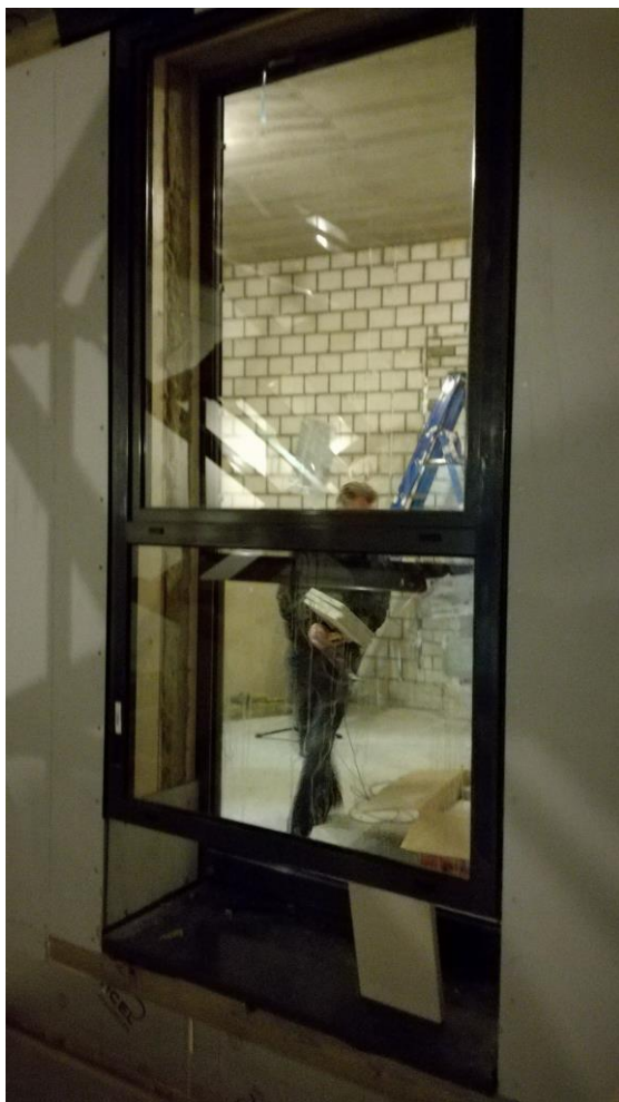
Kozijn buitengevel (meetkamer 3)
