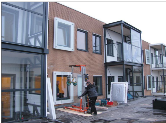
Foto II.1 Aanzicht glazen gevelgeluidschermen
