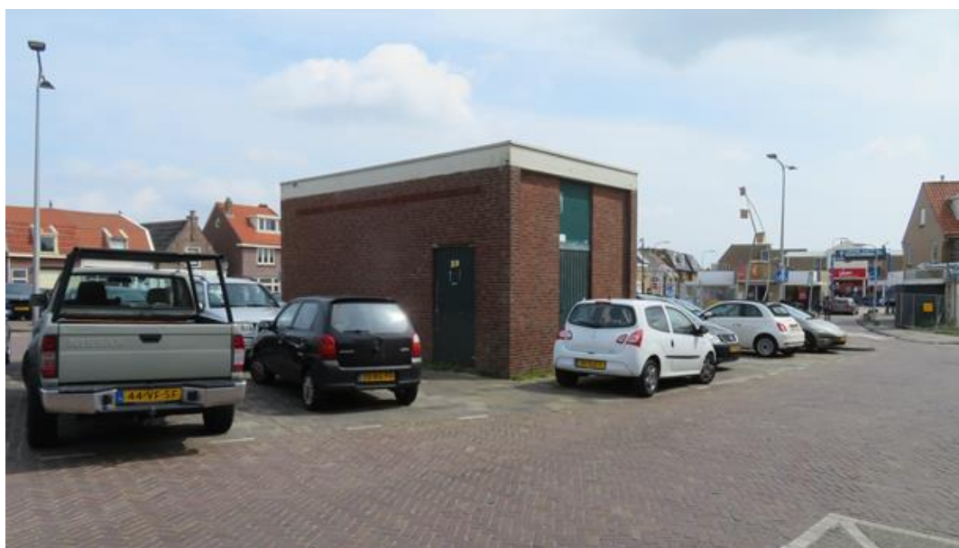
Fig. 5: Gebouw 1: Transformatorhuis op het parkeerterrein.
