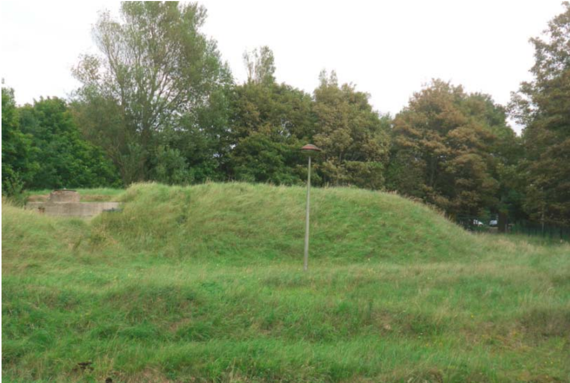
Zuidwestelijke deel met bebouwing: reservoir (onder / in de heuvel, ter plaatse van de niet-gezette boring 5), kijkende in oostelijke richting vanaf nabij boring 2.
