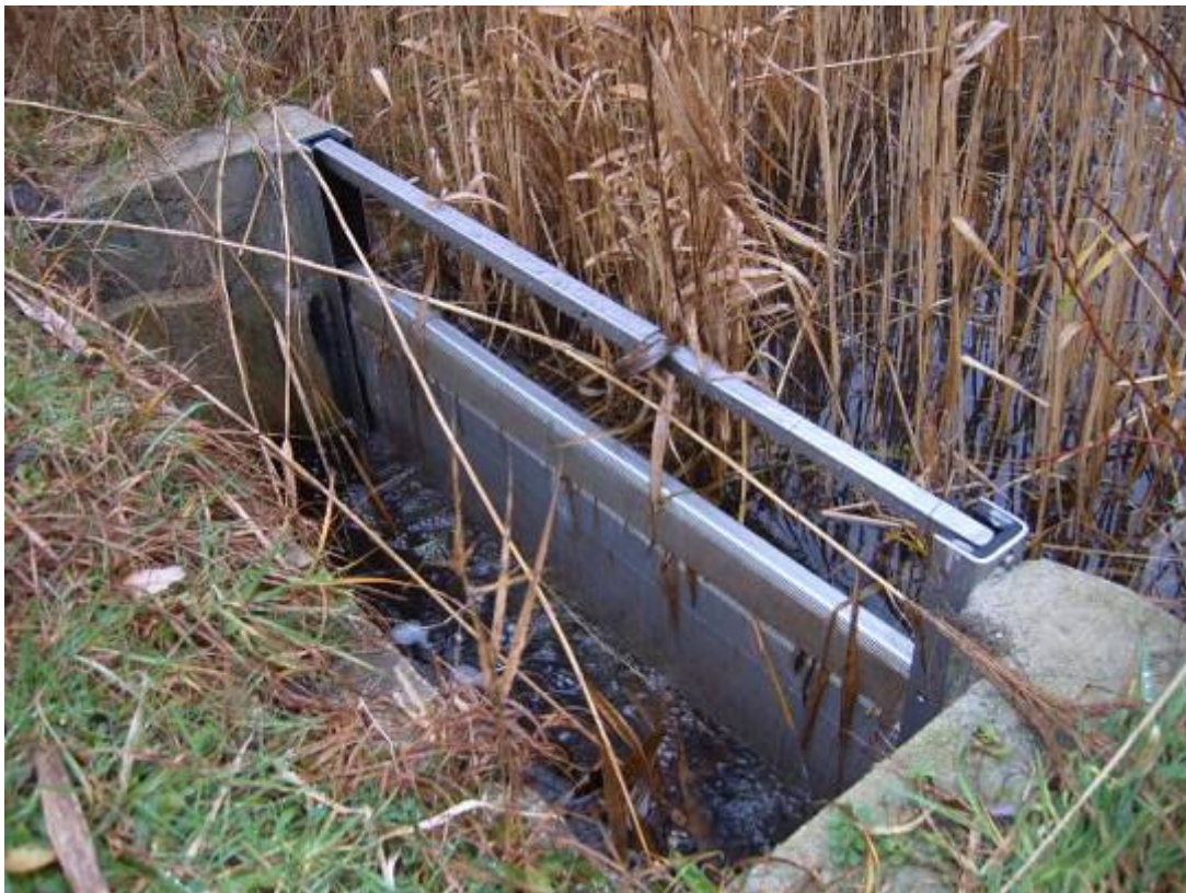
Stuw nr. 1 bij de Langevelderslag
