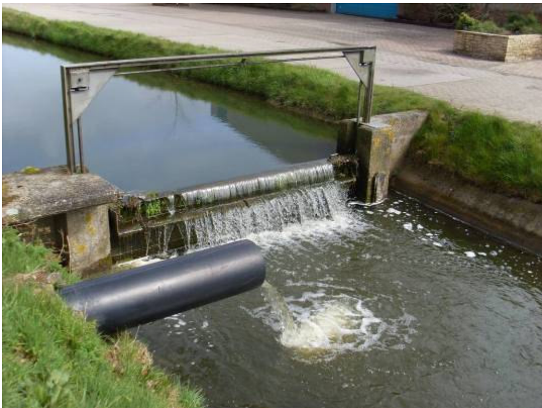
Lozingspunt beneden de stuw van het overtollig water uit natuurgebied Langeveld en DZH-terrein naar Polder Langeveld.
