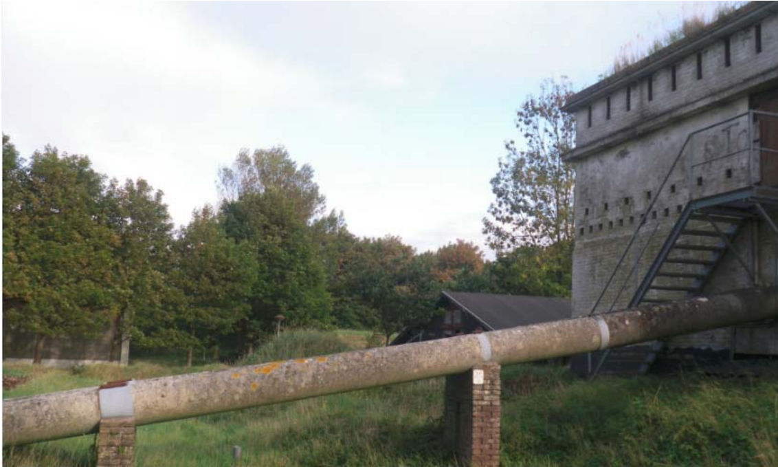
Zuidwestelijke deel met bebouwing: pompstation, kijkende in zuidoostelijke richting vanaf nabij boring 4.
