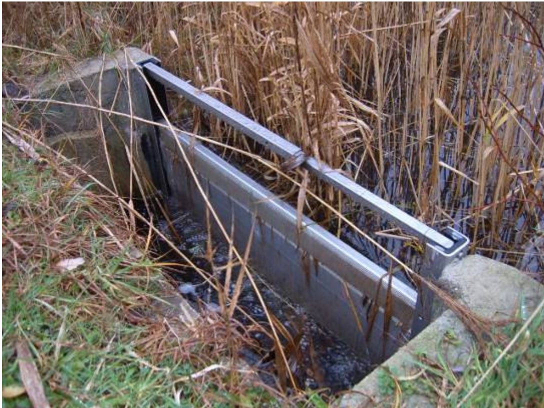
Stuw nr. 1 bij de Langevelderslag
