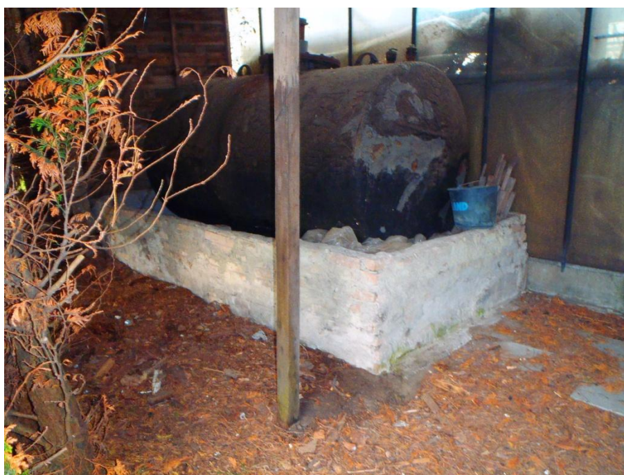
Foto 8: Bovengrondse olietank
