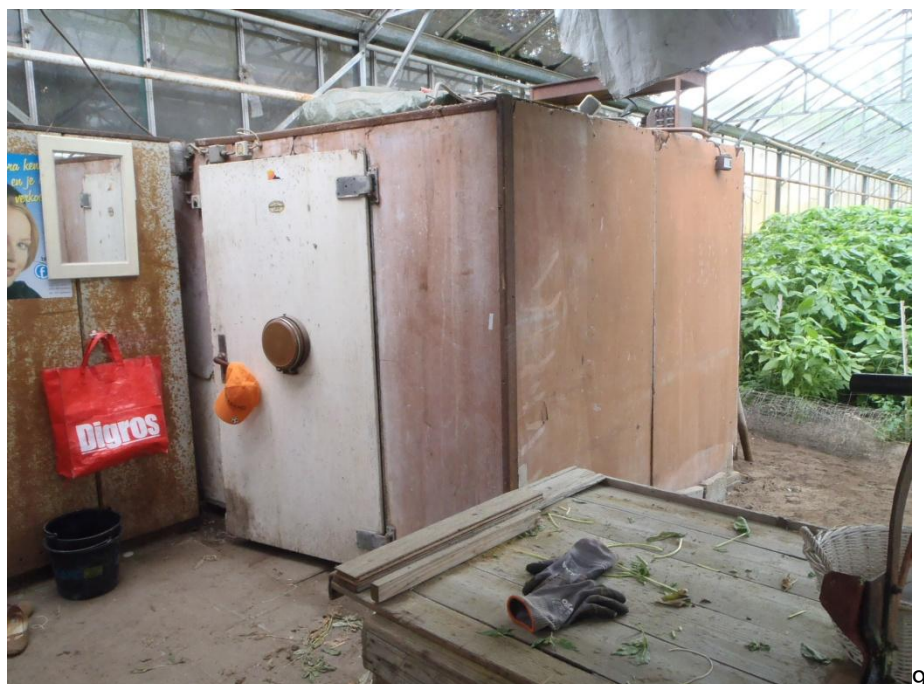
Foto 5: Koelcel met asbest verdachte beplating
