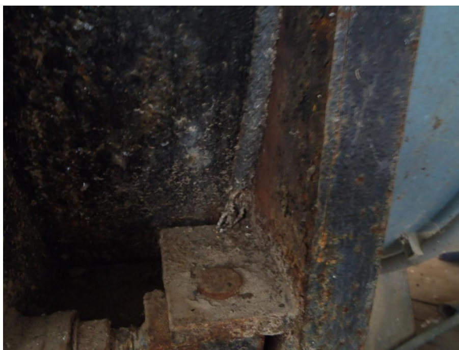
Foto 2: Asbest verdacht koord
