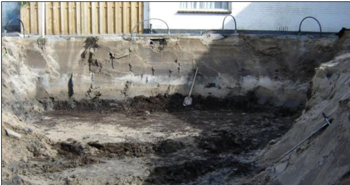
Figuur 8: Sanering tot 2,3 m –mv aan de straatzijde.
