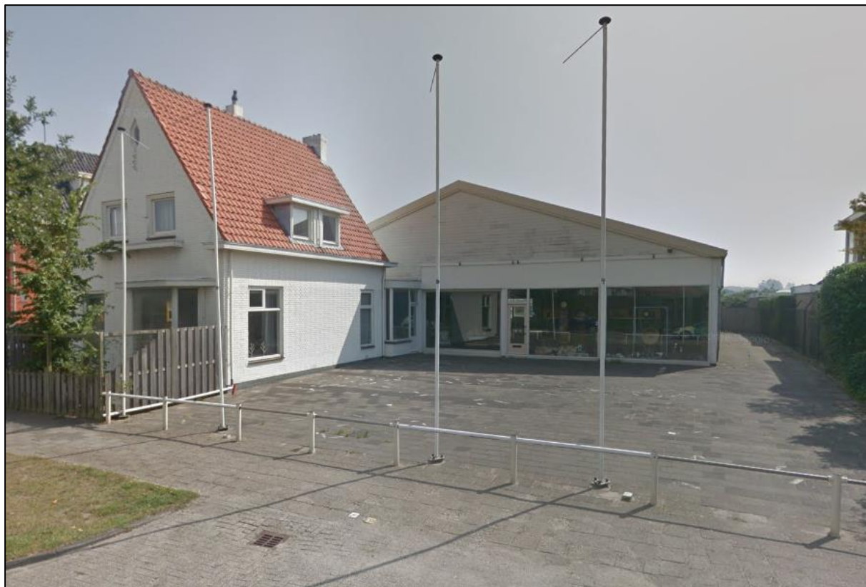
Figuur 14: Het plangebied in augustus 2017, gezien vanaf de Herenweg richting het oosten (bron: Google Streetview).
