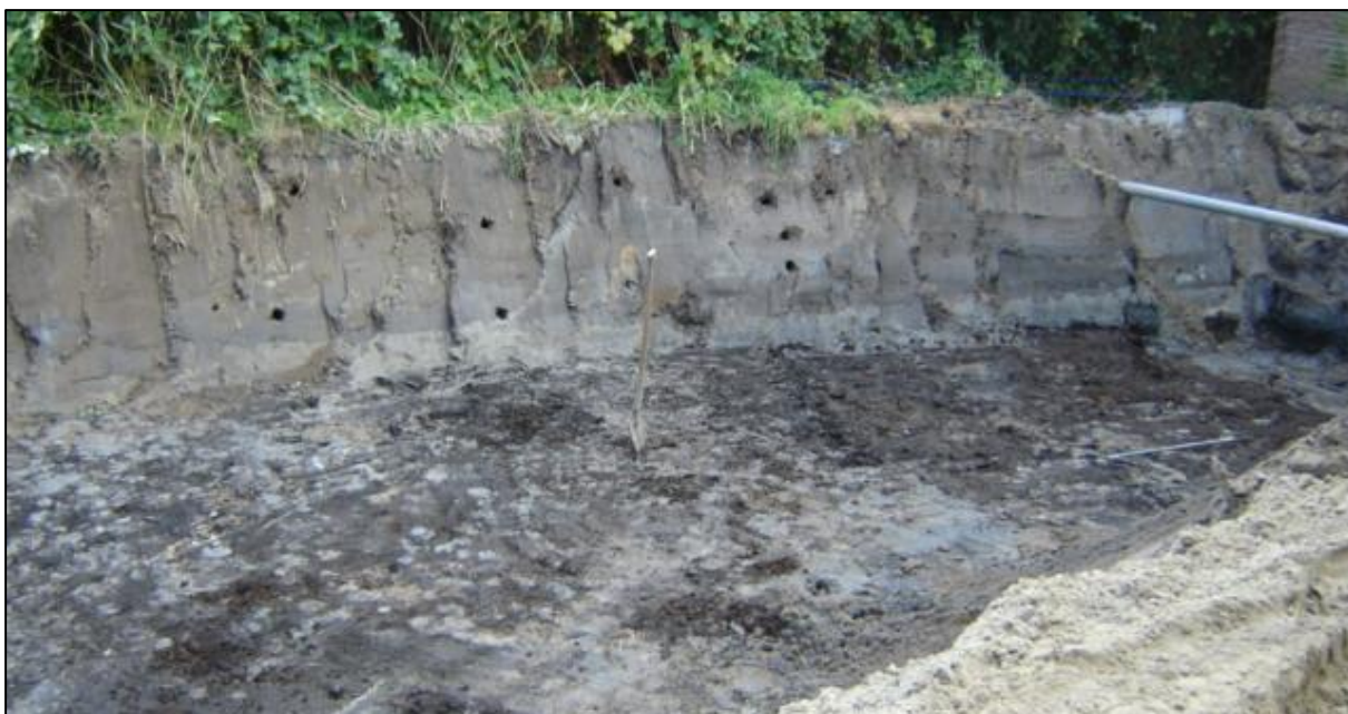
Figuur 9: Sanering tot 1,6 m –mv aan de achterzijde.
