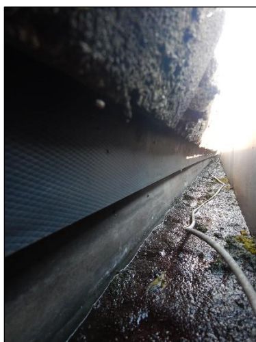
Figuur 8. Overgang dakgoot en onderste rij dakpannen aan oostzijde restaurant.
