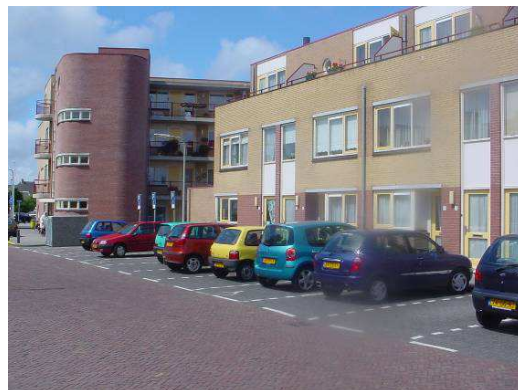
Afbeelding: gestapelde woningen aan de Hoogwakersbosstraat
