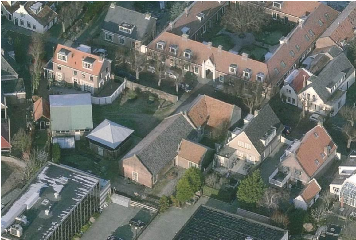
Voormalige situatie Pickéstraat 7-7a, bijgebouwen en achterhuis inmiddels gesloopt.
