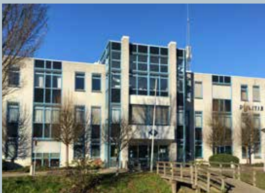
kantoorgebouw aan de Duinwetering
