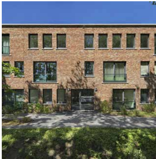
Gevarieerde opbouw van de gevel
