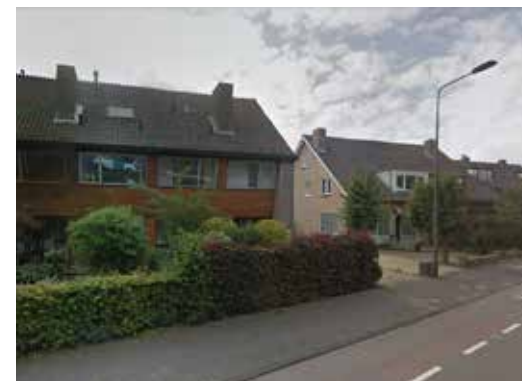
Twee-onder-één-kapwoningen aan de Duinwetering
