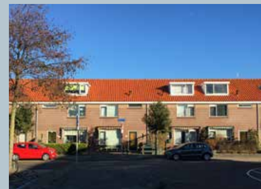
Bestaande woningen aan de Susanna van Ettenstraat
