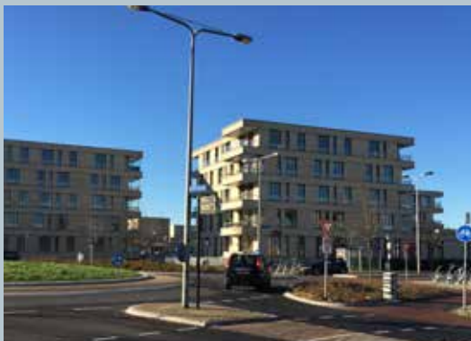
Appartementen Van Panhuysstraat/Weteringkade
