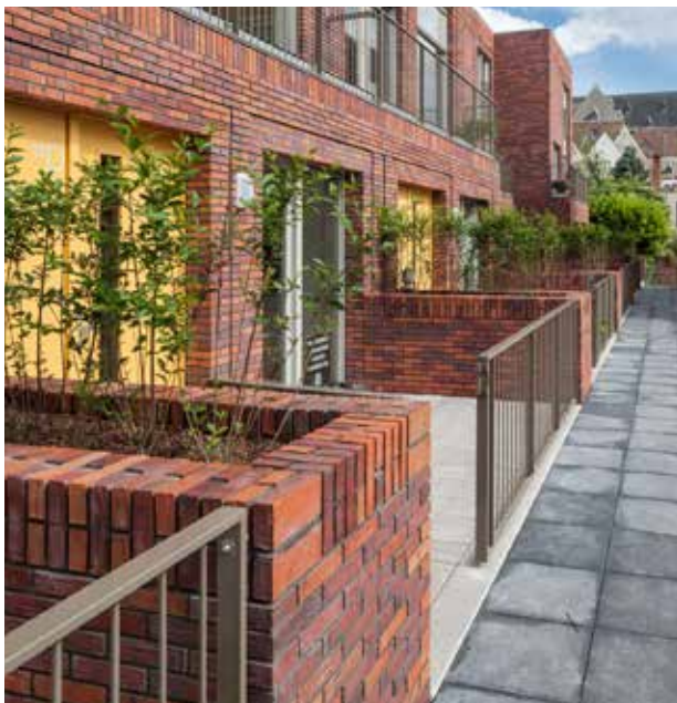
30 Lage erfafscheiding woningen aan het hof
