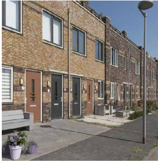
Rustige en eenvoudige gevelindeling
