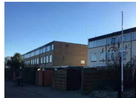
Woningbouw aan de Johanna van Hoornstraat
