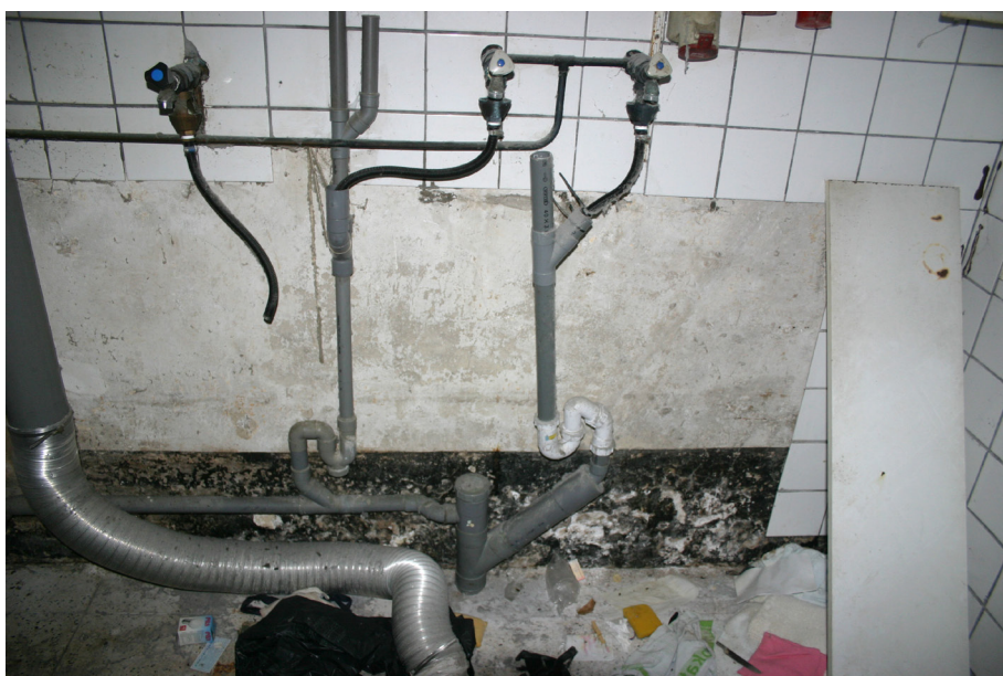
Afb. 30 Voorstraat 79. De rechterwand van de overbouwde poortdoorgang.
