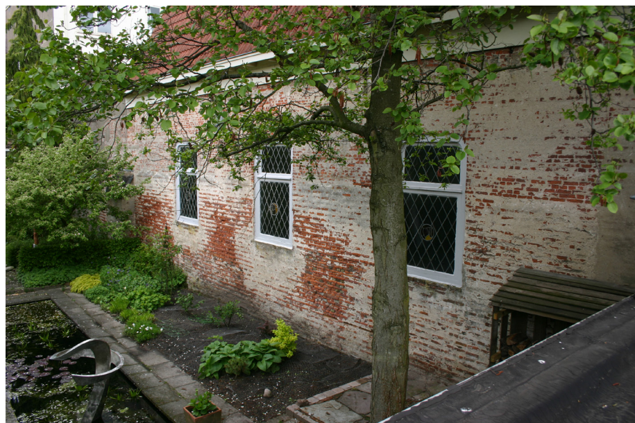
Afb. 27 De rechterzijgevel van de Ridderzaal waarvan wordt vermoed dat het een opgehoogde tuinmuur betreft.
