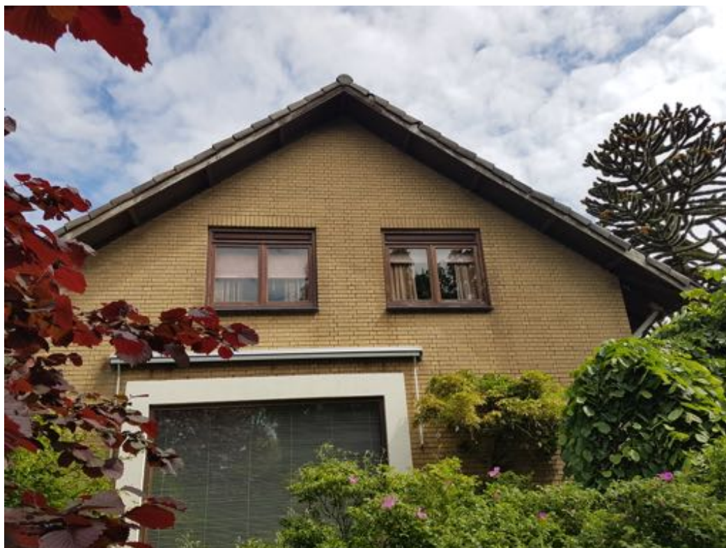
Figuur 2 Zuidzijde van de woning. In het dak bevinden zich openingen die kunnen dienen als broedlocatie voor broedvogels en als rust/verblijfplaats voor vleermuizen.
