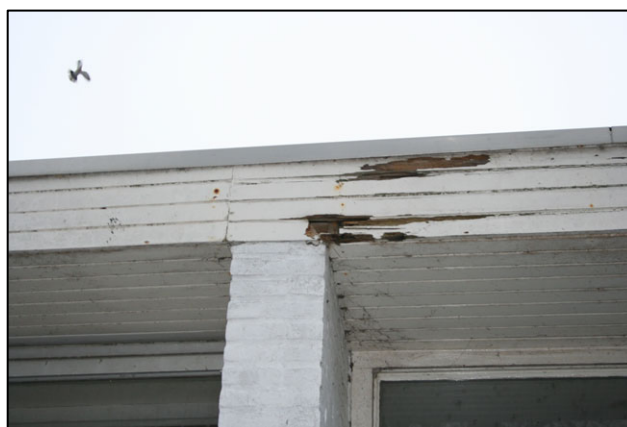
Besloten gelegen, zuidelijke deel van de schoolgebouwen met in de dakrand duidelijk zichtbare invlieg mogelijkheden voor vleermuizen.
