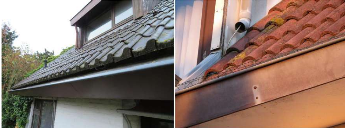
Aaneengesloten dakpannen bij alle panden.
