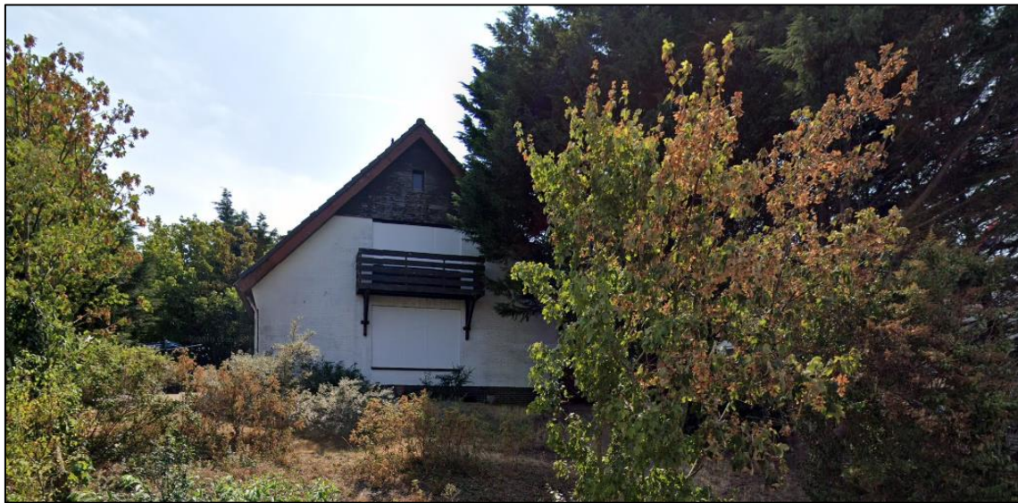
Figuur 5: Beeld van de Prins Hendrikweg 17 gezien vanaf de weg (Google Streefview)
