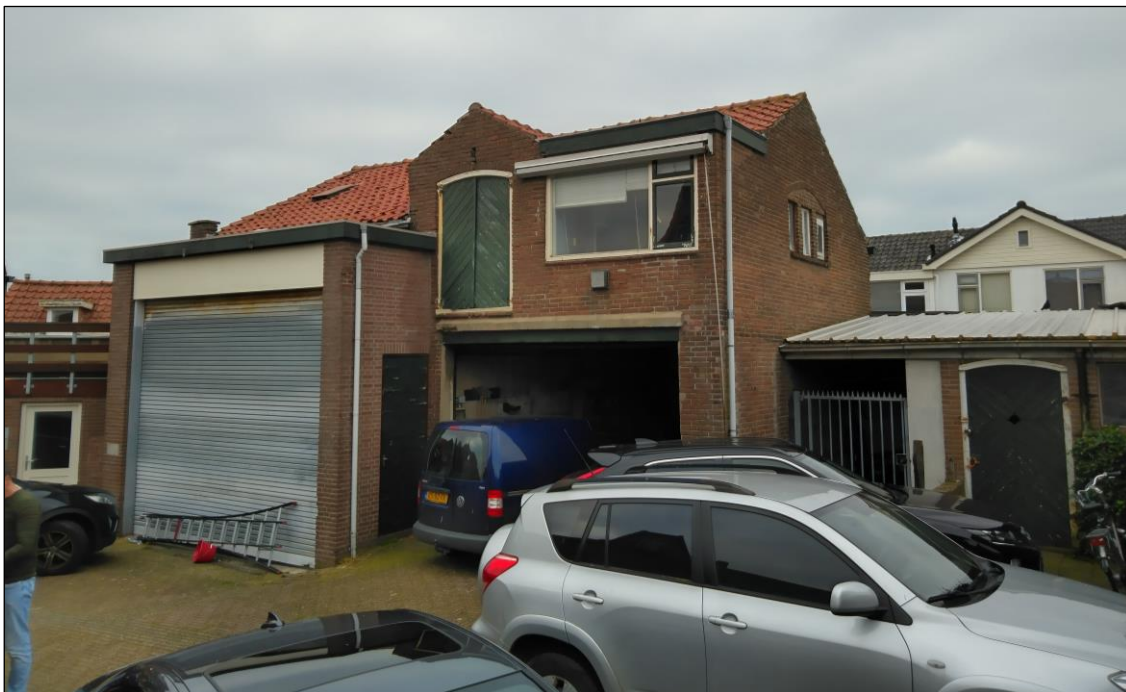
Figuur 11: Foto 1 aanzicht opslag
