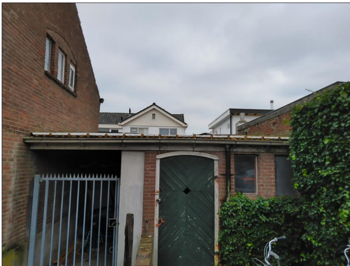
Figuur 12: Foto 2 verlaagd rechter bouwdeel
