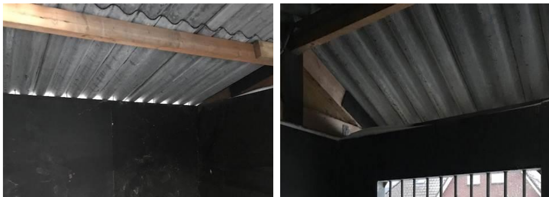
Figuur 7: Balken aan binnenzijde paardenstal waar de boerenwaluwen kunnen broeden.
