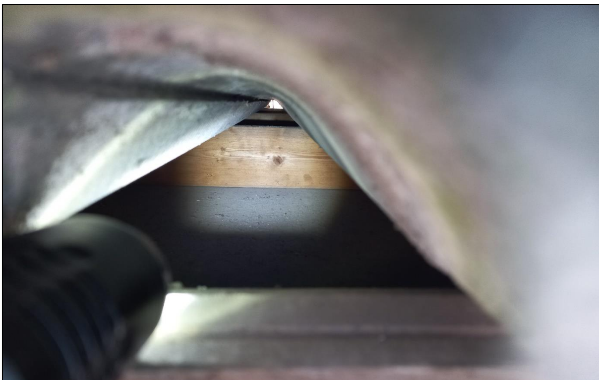
Figuur 3: De dragende balken zijn 20 cm hoog.
