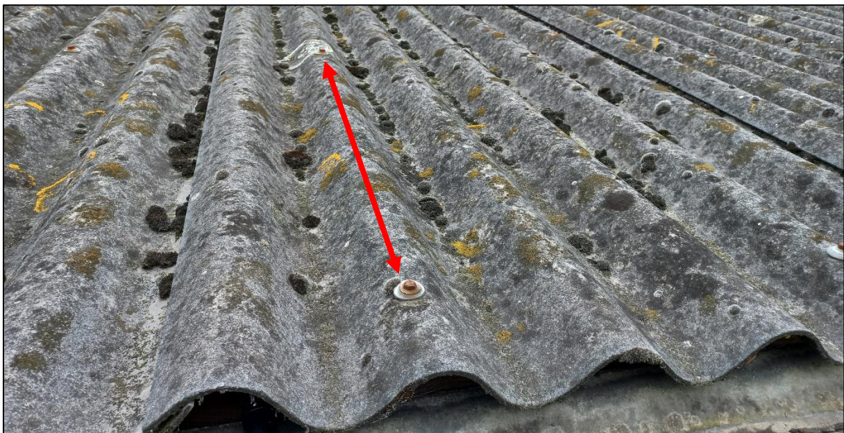
Figuur 2: De ruimte tussen de dragende balken bedraagt één meter (rode pijl).
