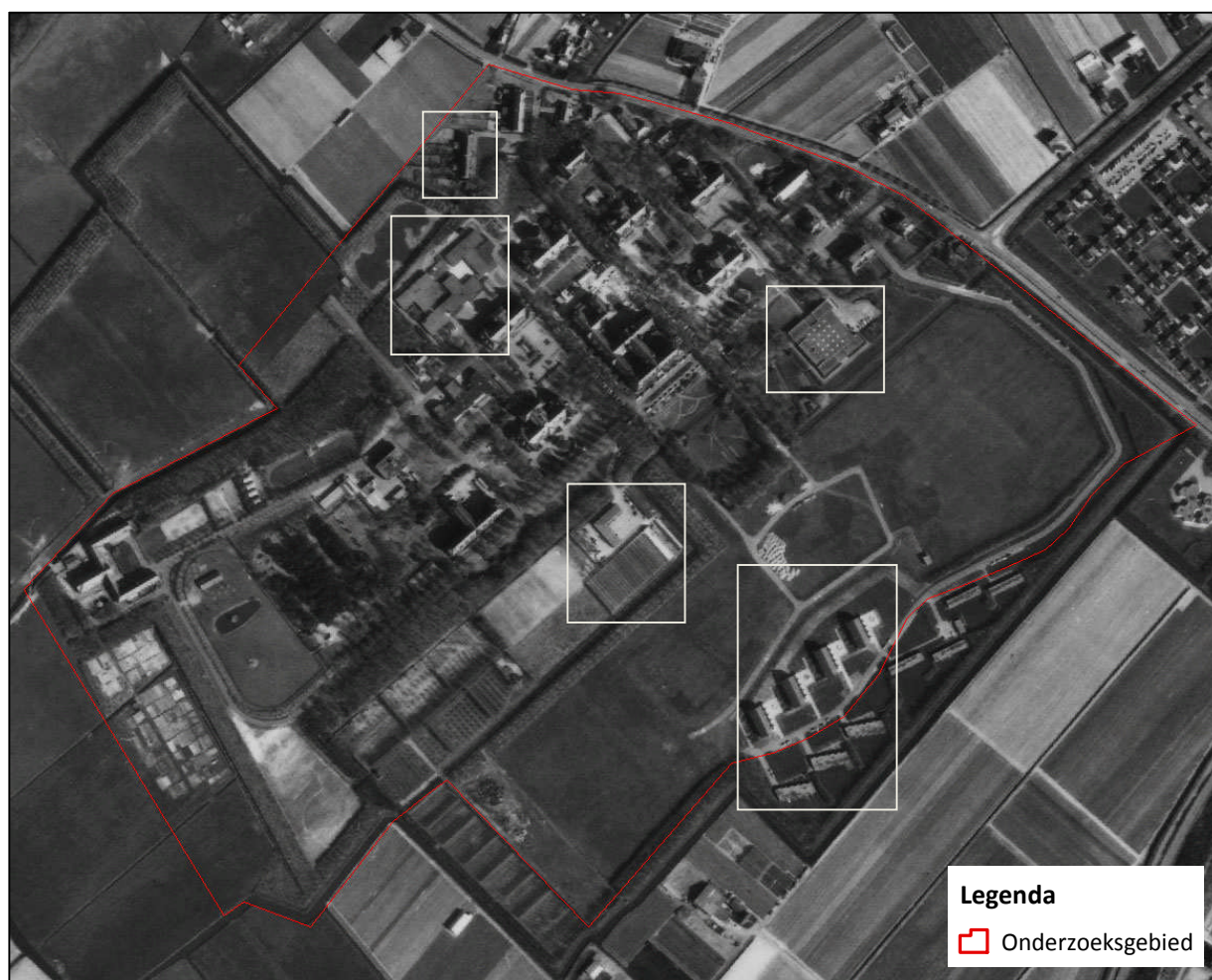
Figuur 38: Luchtfoto 24-803-1977 uit 1977. Op diverse locaties in het onderzoeksgebied zijn nieuwe gebouwen verzeen.
