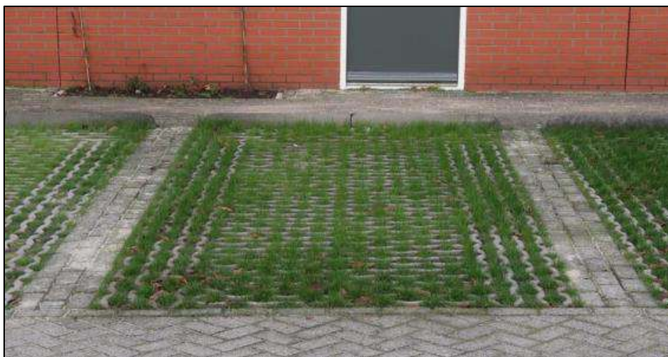
Figuur 9: Halfverharding bij parkeerplaatsen (bron:duurzaamdenhaag.nl).
