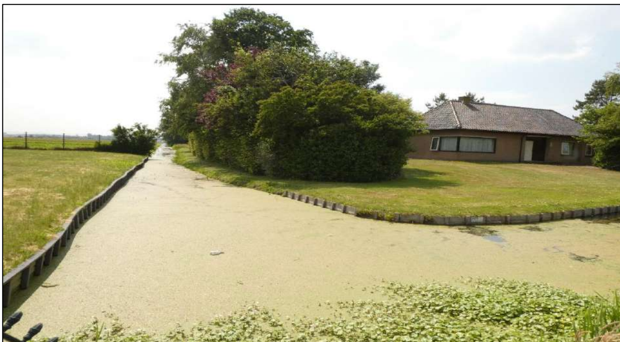
Figuur 4: De te slopen woning op Duindamseweg 1. Rondom het plangebied loopt een sloot met houten oeverbeschoeiing. De sloot heeft een dikke krooslaag en in de hoek is de invasieve exoot grote waternavel aanwezig. Het gazon rondom de woning is kortgemaaid en de tuin is strak onderhouden. Rondom de woning zijn bomen en bosschages aanwezig.
