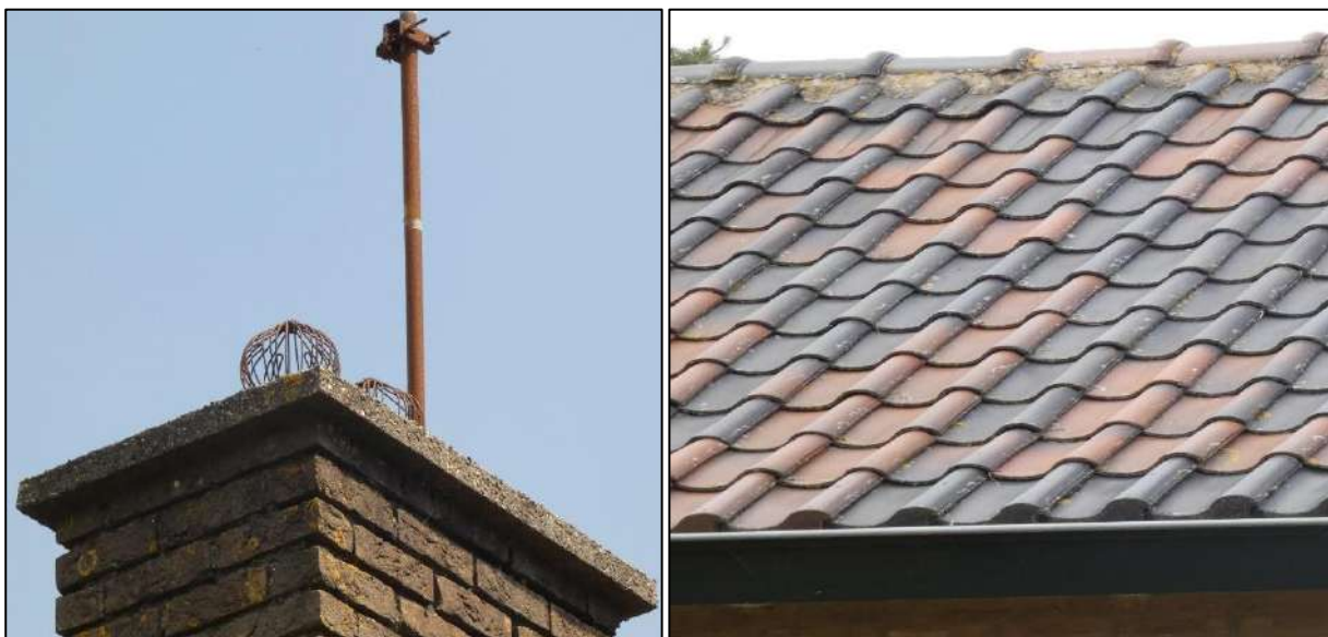
Figuur 11: Vogelwerend materiaal in de schoorsteen, aangesmeerde nokpannen en dakpannen met opstaande rand aan de woning op nummer 1. Hierdoor zijn de schoorsteen, de dakgoot en het dak niet toegankelijk voor vogels of vleermuizen.
