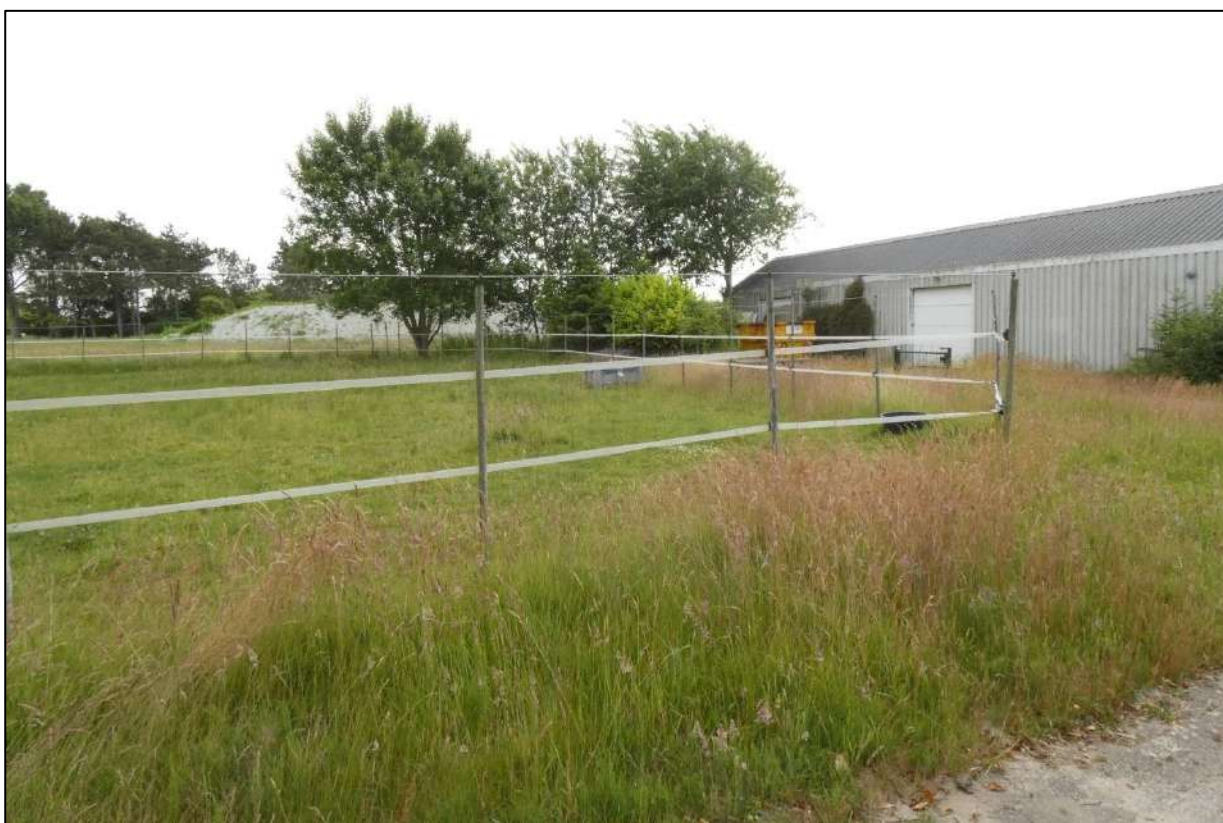
Figuur 7: De paddock en te slopen vrijstaande loods op Duindamseweg nummer 3. Achteraan op de foto is de zandberg te zien gelegen op het graslandperceel tussen nummer 1 en 3. Op de percelen komen nieuwbouwwoningen.
