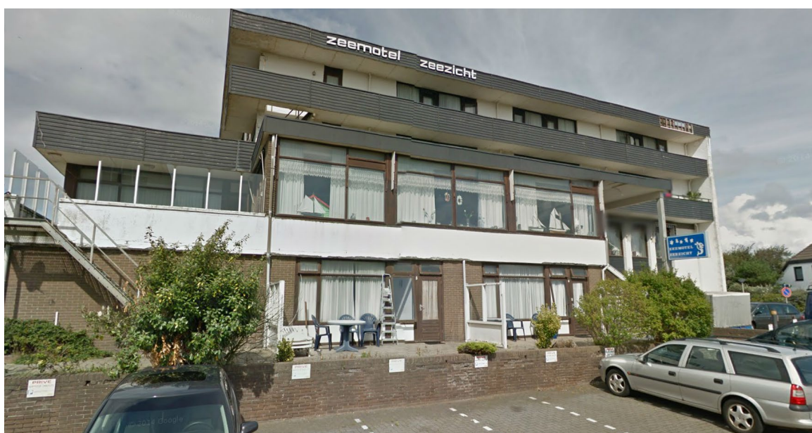
Afbeelding 2.1: voormalige situatie zuidzijde, gezien vanaf Erasmusweg
