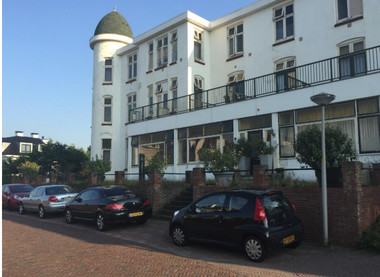
figuur 9. Te verlagen talud (zie opgaande muur) van +/- 1,70 meter
