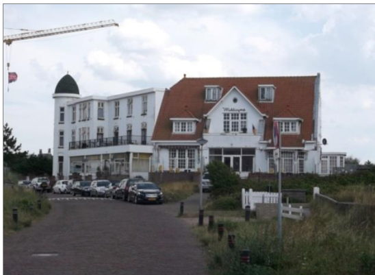
Foto 1: De voormalige hotels gezien vanuit het westen, het pannendak behoort tot Midduyne.
