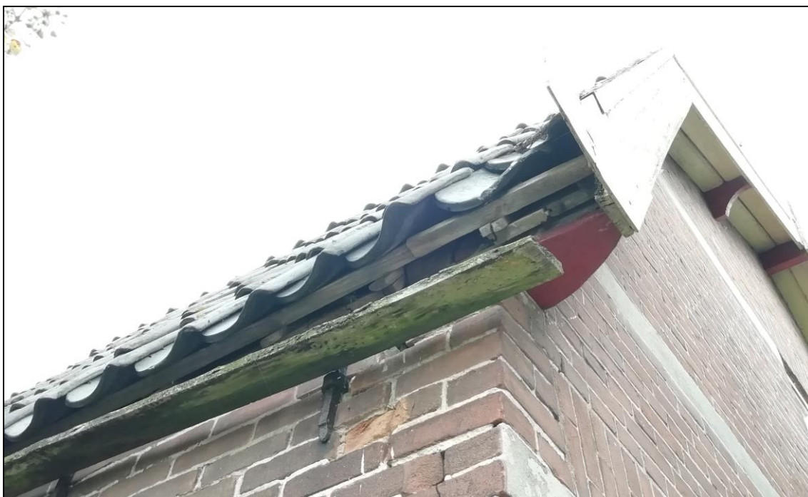
Figuur 7: Slechte in- en uitvliegmogelijkheden voor huismus, gierzwaluw en vleermuizen aan de zij- en voorgevel van de Wassenaarseweg 8. Enige mogelijkheid is richting de weg.
