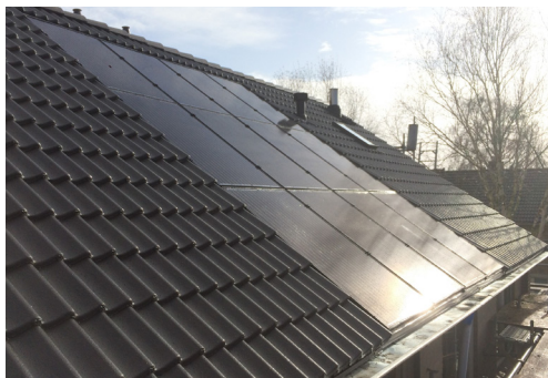
zonnepanelen in het dak geïntegreerd
