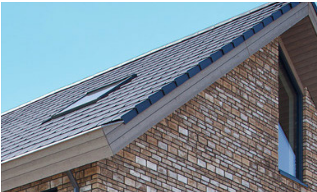
aluminium of houten getimmerde dakranden en goten
