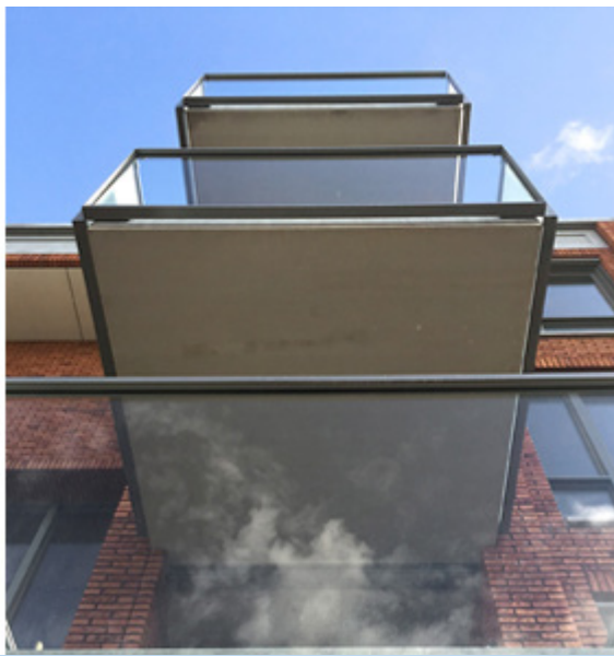
boven elkaar geplaatste uitkragende balkons
