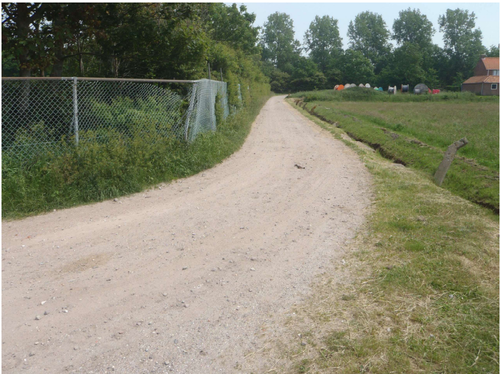
Foto 04 puinpad vanuit noordwestelijke richting
