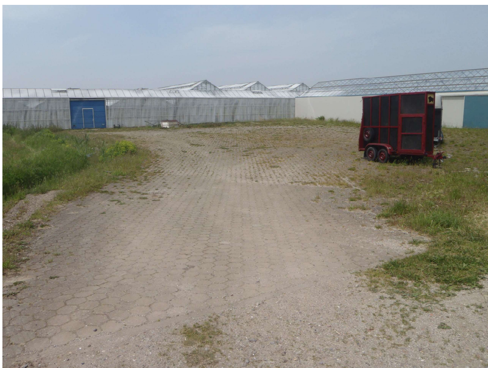
Foto 06 klinkerverharding kassencomplex vanuit zuidelijke richting
