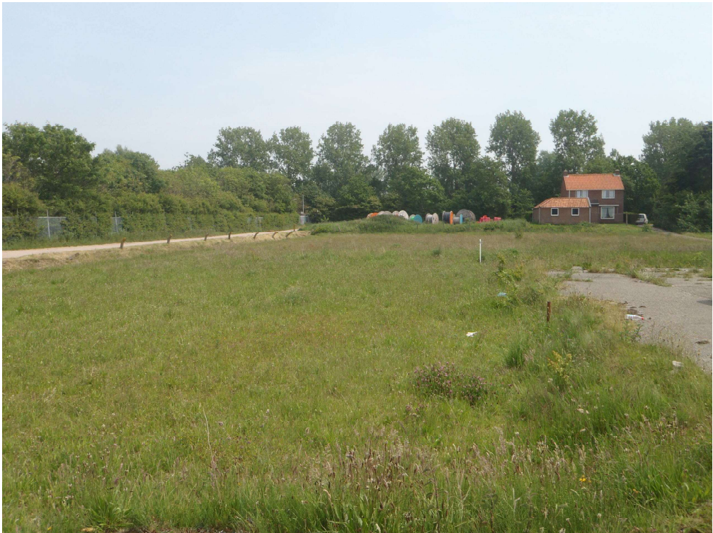
Foto 03 vanuit noordwestelijke richting
