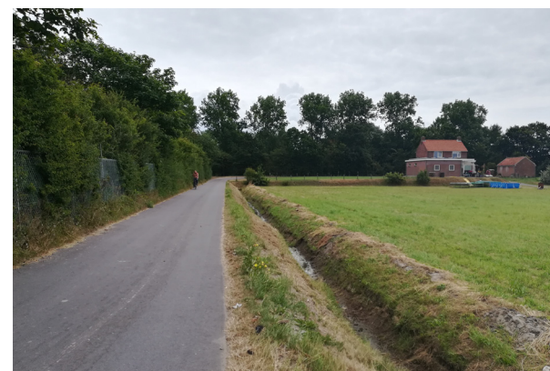
Zeestraat met bestaande greppel
