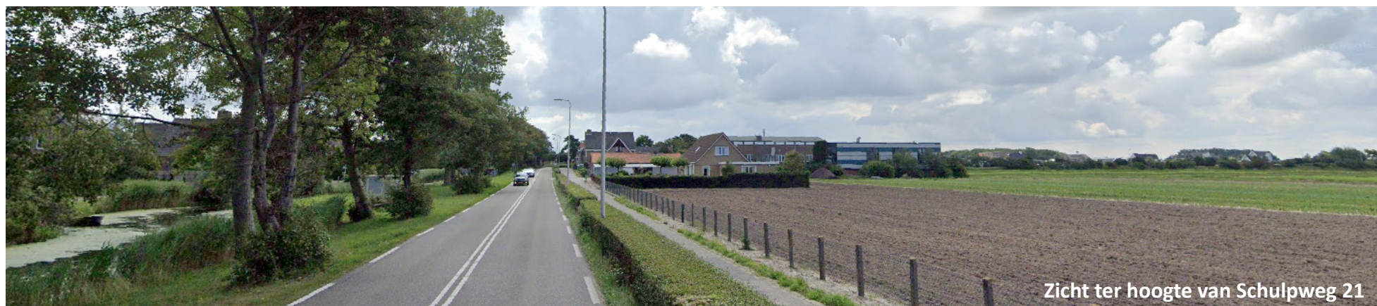
Zicht ter hoogte van Schulpweg 19
