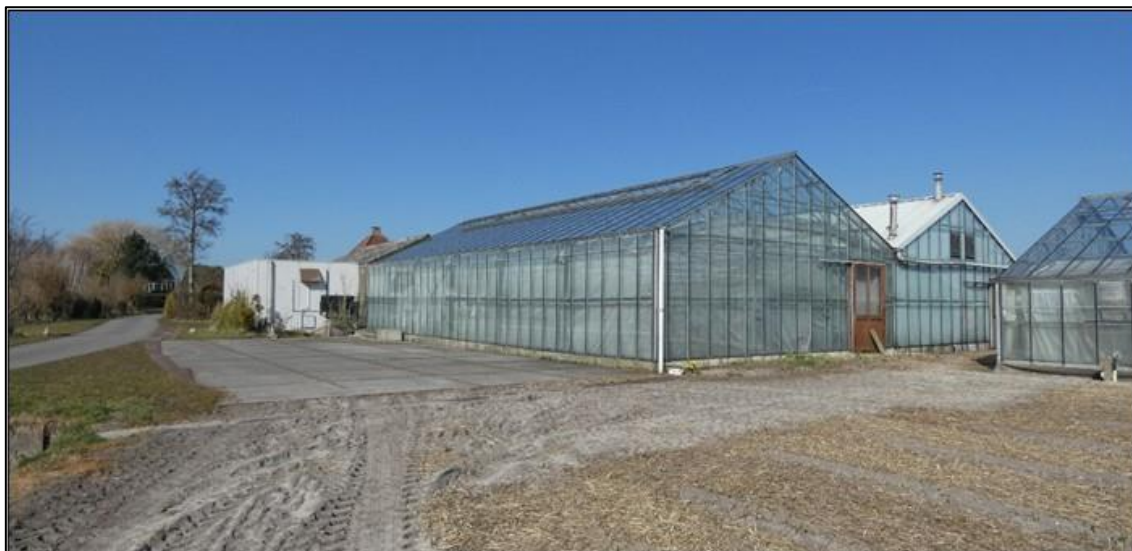
Figuur 7: Een deel van de te verwijderen glazen kassen
