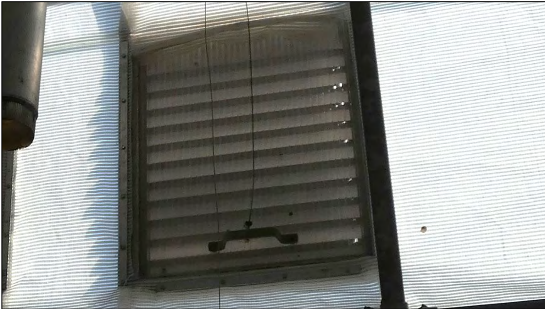
Figuur 15: Ventilatioeroosters van de kassen, aan de binnenzijde afgewerkt dat dieren hier niet doorheen kunnen.
