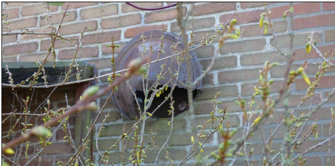
Figuur 11: De oude ventilatie, aan de binnenzijde dicht gemaakt. Beschermde soorten worden hier niet verwacht.
