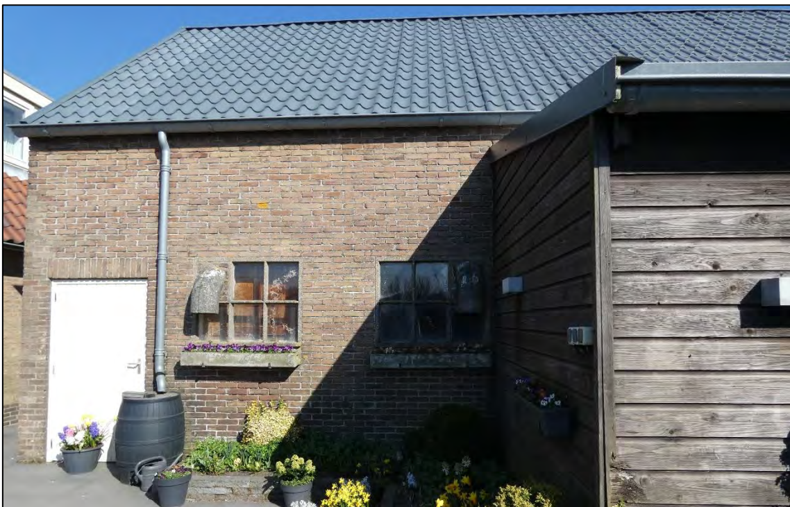
Figuur 10: De te slopen asbesthoudende schuur en te slopen houten schuur. In beide opstellen is geen potentie aanwezig voor beschermde soorten.
