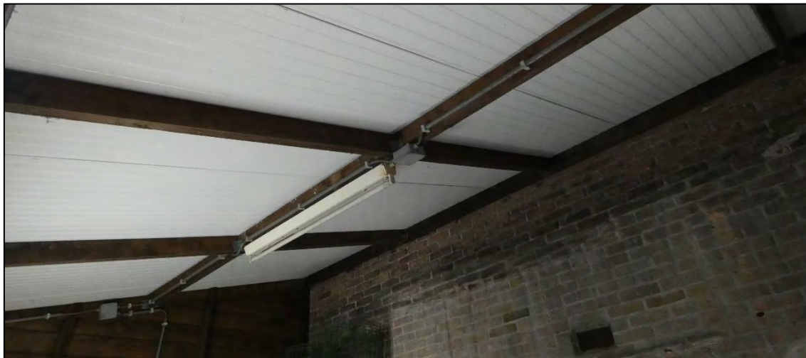
Figuur 13: Binnenzijde houtenschuur, er is geen dakbeschot aanwezig. Beschermde soorten worden hier niet verwacht.
