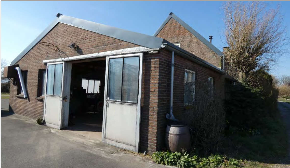
Figuur 9: De te slopen grote schuur, er is in dit opstal geen potentie voor beschermde soorten aanwezig.
