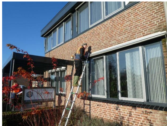
Figuur 16 Onderzoek sporen vleermuizen
