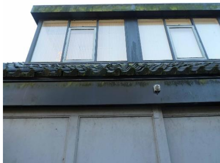
Figuur 12 Dak kantoorpand
