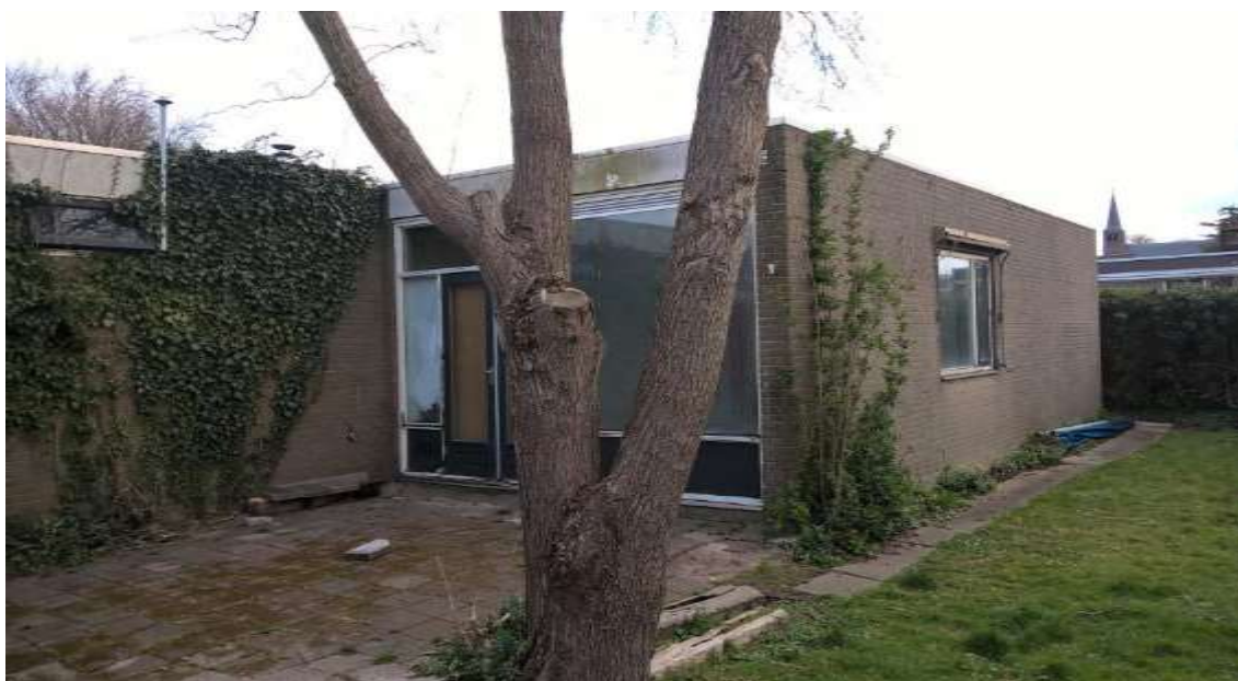
afbeelding 4: achterzijde bestaande situatie
