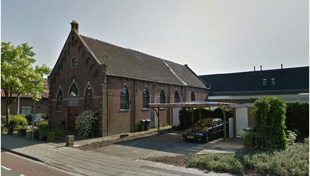
Figuur 3-6 Aanzicht hoofgebouw Kerkstraat 2 bestaande uit twee delen, zie de uitsnede in het dakvlak
