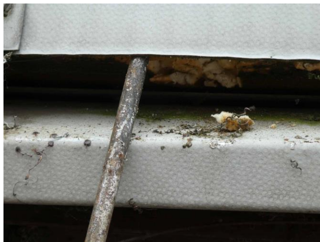
Figuur 14: Detail dak met isolatiemateriaal
