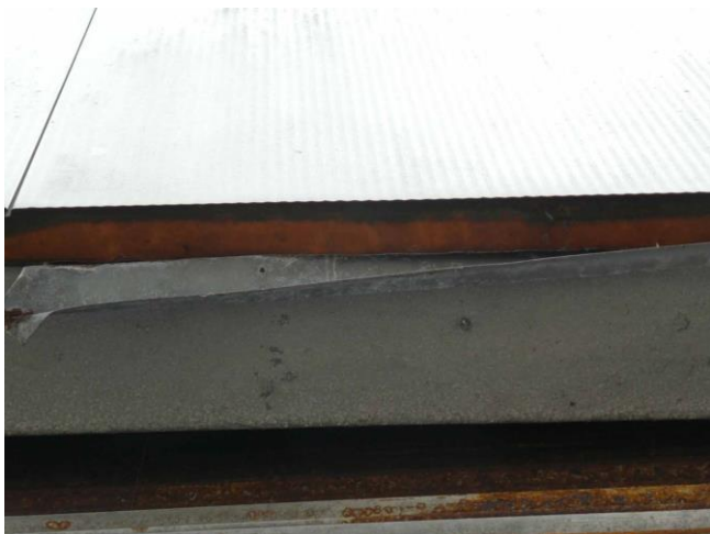
Figuur 13: Isolatiemateriaal achter trespaplaten
