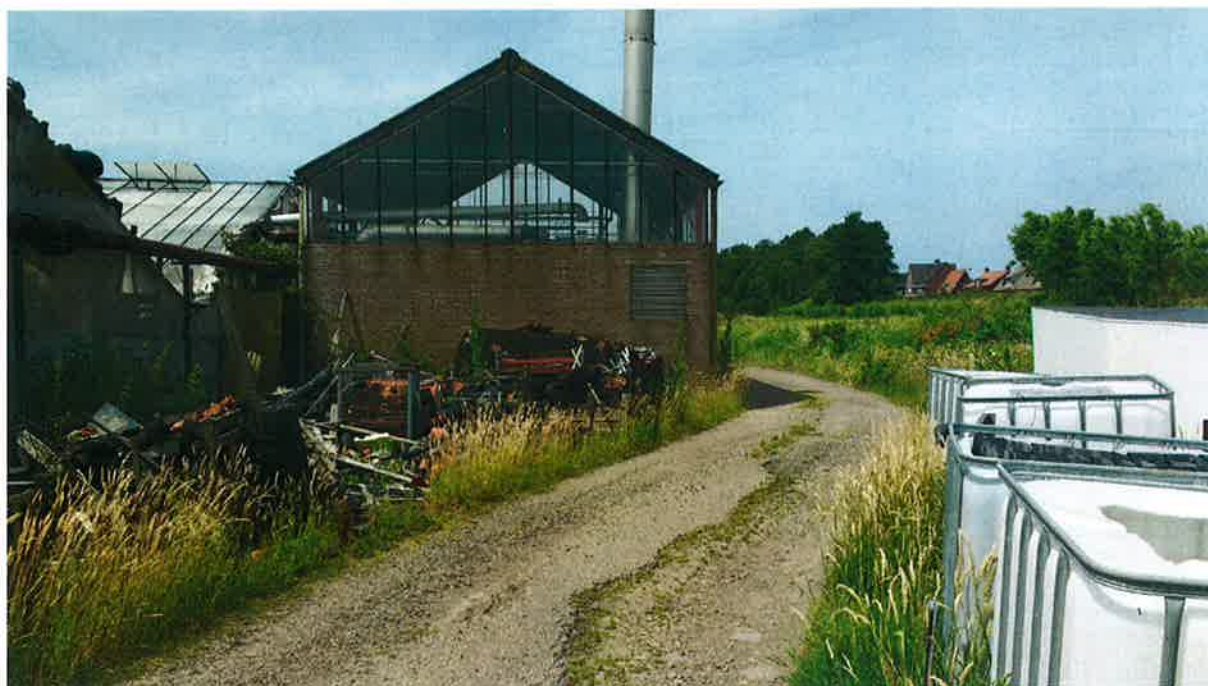
Bovengondse olietank naast ketelhuis in betonnen bak op gedempte sloot
