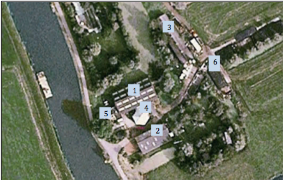
Afbeelding 10: Huidige bebouwing Grechtkade 10
