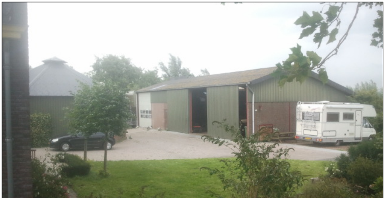
Afbeelding 5: Vooraanzicht bestaande bebouwing
