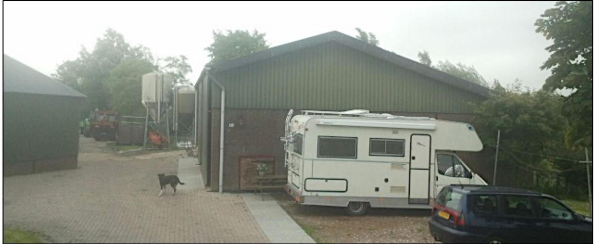
Afbeelding 4: Vooraanzicht bestaande bebouwing
